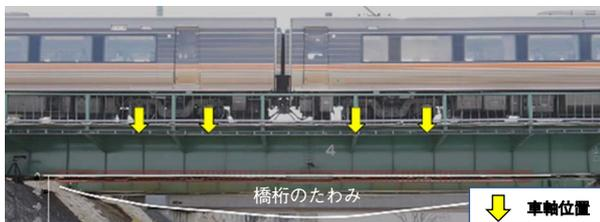
第6図 最大たわみ発生時刻の列車位置と橋桁たわみ
