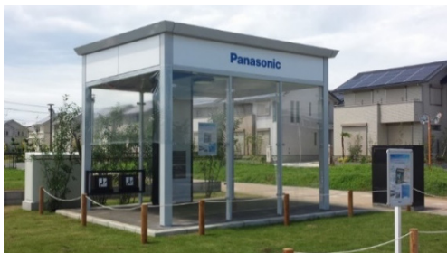
第5図 藤沢市での実証実験 Fig.5 Field test in Fujisawa city
